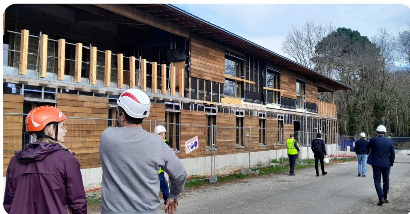
VISITE DU CHANTIER DE LA MAISON DE LA PETITE ENFANCE, À SAINT-MÉDARD-EN-JALLES (33), FÉVRIER 2026
